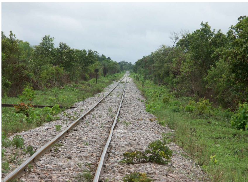
Figura 28: La actual ferrovía de Santa Cruz a Puerto Suárez muestra pérdidas de alineación del carril, que denotan un insuficiente mantenimiento y reducen la calidad de servicio de la línea. Las deformaciones de la vía se deben fundamentalmente al uso de la misma, es decir al transporte por ésta de cargas pesadas. Las deformaciones que se muestran en la foto son características de un bajo mantenimiento de la vía, no de una mala construcción del terraplén o de clima severo. (Foto: Anton SEIMON 2005)
