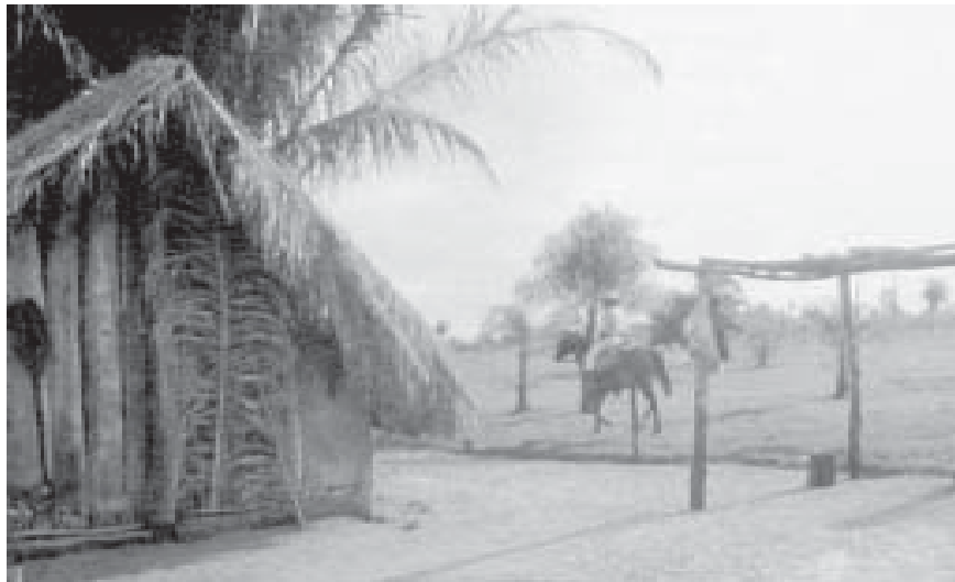
FIGURA 2 - ABRIGO VERNACULAR REALIZADO COM FOLHAS DE ACURI E COBERTURA EM PALHA: O PANTANEIRO ENCONTRA NO PRÓPRIO MEIO AS FORMAS DE PROTEÇÃO (FOTO DE MARIO RAMIRES E RAIMUNDO ALVES FILHO. NOGUEIRA, 2002)
