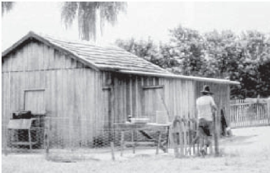
FIGURA 3 - RANCHO DE BARROTES QUE SERVE DE MORADIA AOS PEÕES: AMBIENTES ESPAÇOSOS SUBSTITUÍDOS POR PADRÕES URBANOS NO CASO DAS CASAS DOS PATRÕES (FOTO DE MARIO RAMIRES E RAIMUNDO ALVES FILHO. NOGUEIRA, 2002)
