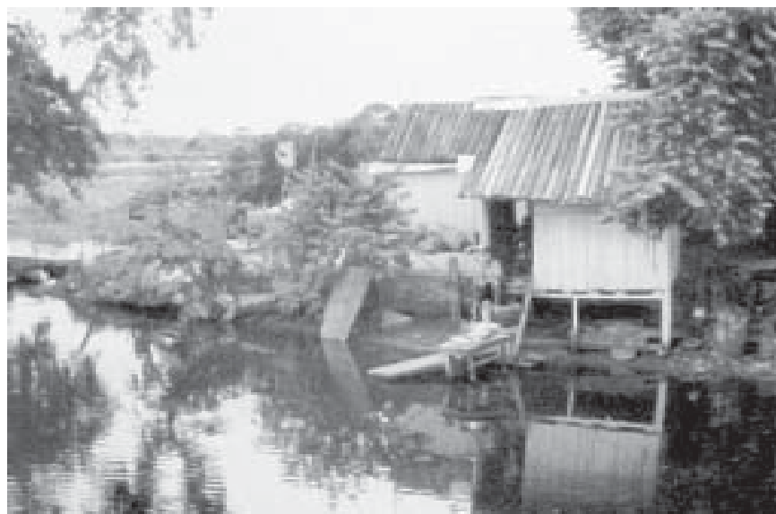
FIGURA 4 - HABITAÇÕES ESPONTÂNEAS EM PALAFITAS ÀS MARGENS DE CURSOS D'ÁGUA: ADAPTAÇÃO VERNACULAR ÀS CHEIAS SAZONAIS E AO MODO DE VIDA LOCAL (FOTO DE MARIO RAMIRES E RAIMUNDO ALVES FILHO. NOGUEIRA, 2002)
