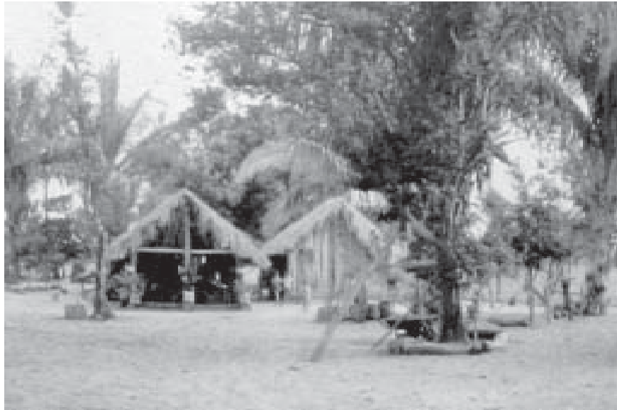
FIGURA 5 - RANCHO BEIRA-CHÃO COMPOSTO POR MATERIAIS NATURAIS E TÉCNICAS ARTESANAIS: PALMAS DE ACURI, BABAÇU OU BOCAIÚVA SERVINDO DE PAREDE E COBERTURA (FOTO DE MARIO RAMIRES E RAIMUNDO ALVES FILHO. NOGUEIRA, 2002)
