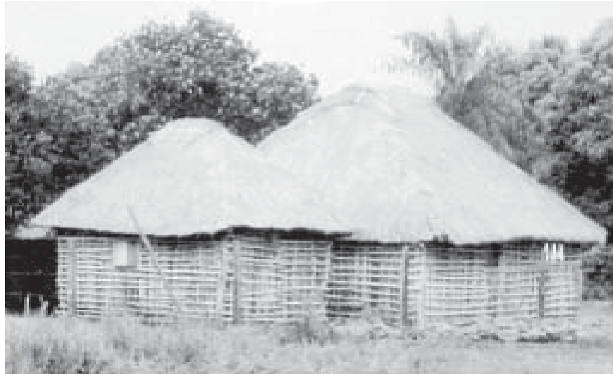
FIGURA 1 - CONSTRUÇÕES COM PAREDES EM PAU-A-PIQUE E COBERTURA EM CAPIM SAPÉ: ADEQUAÇÃO VERNÁCULA ÀS CONDICIONANTES DO MEIO NATURAL (FOTO DE MARIO RAMIRES E RAIMUNDO ALVES FILHO. NOGUEIRA, 2002)
