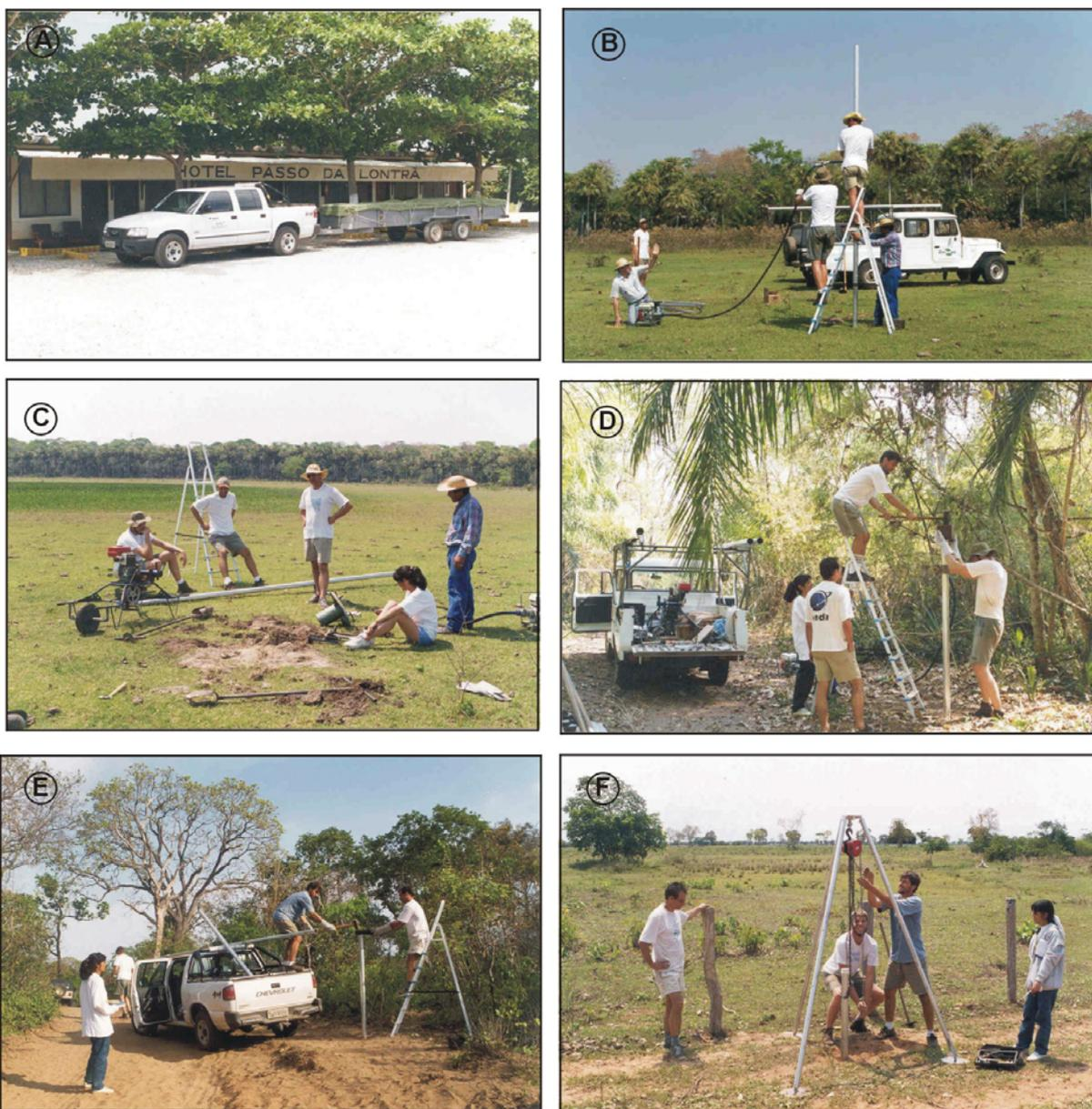
Figura 5 – Cenas dos trabalhos de campo: A) carreta utilizada para transporte dos equipamentos; B) tentativa de cravar tubo de 6m com vibrotestemunhador; C) desalento após insucesso de amostragem com vibrotestemunhador e trado mecanizado; D e E) testemunhagem a percussão com a utilização de marretas para cravar os tubos foi a única alternativa viável; F) recuperação dos tubos com tripé e talha manual.
