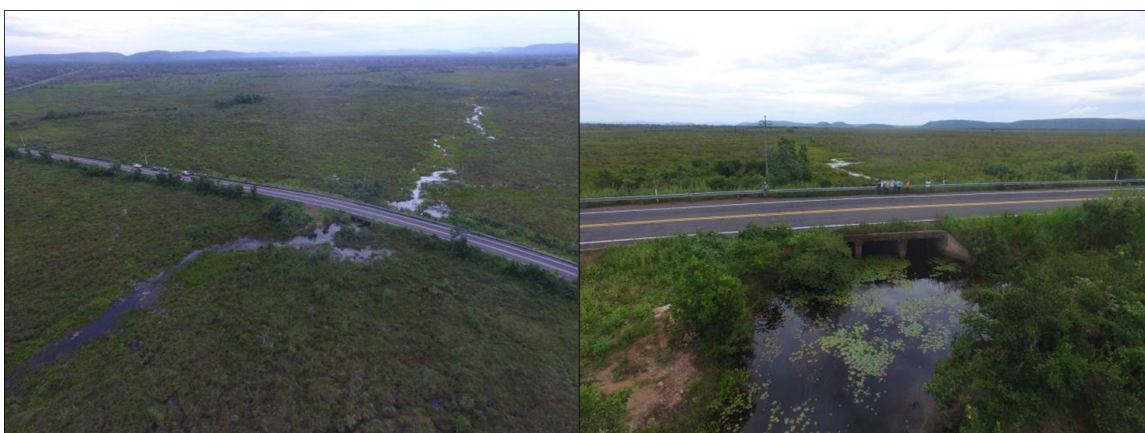
Figura 8: Registro da galeria instalada sobre o Córrego Cupim que atravessa a rodovia MT-040
