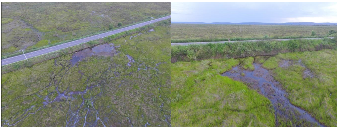
Figura 9: Registro do local de estagnação das águas, barramento causado pela Rodovia MT-040
